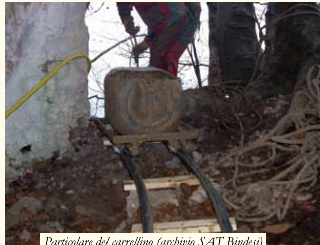
Particolare del carrellino (archivio SAT Bindedi)
